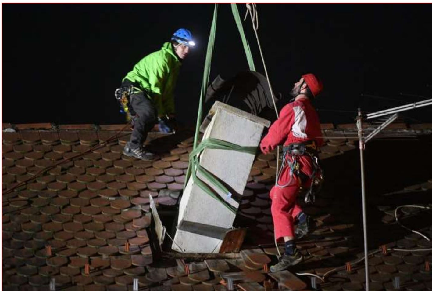
Slika 4. Članovi AO HPD Zagreb Matica uz pomoć volonterskog krana uklanjaju porušeni dimnjak
